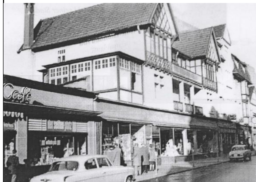
5f Lange Straße 55, Textilgeschäft, Barkhausen, Ansicht 1970
